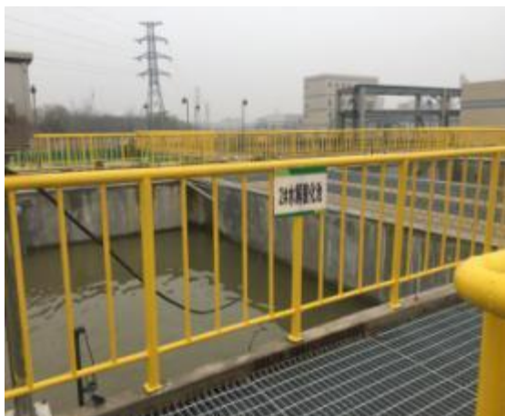
图 3-23 污水处理站水解酸化池
