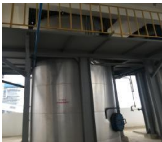
图 3-34 氯化苧生产废气处理设施
