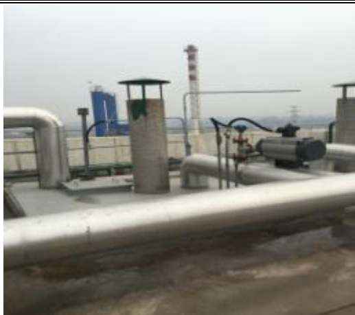
图 3-35 氯化苧生产废气排口
