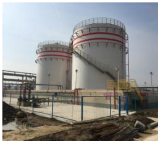
图 3-40 储罐围堰
