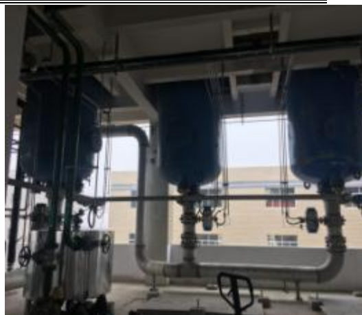
图 3-36 苯甲醇生产废气处理设施
